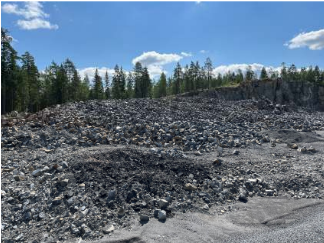
Kuva 3. Alueella on vielä irrotettua, murskaamatonta louhetta viimeisimmän louhintakerran jäljiltä.
