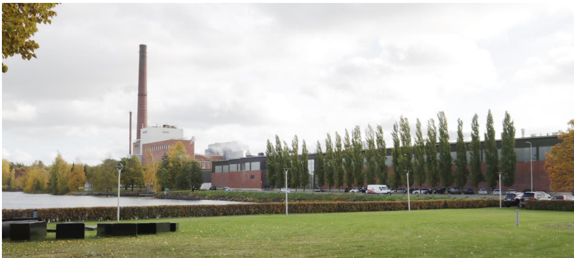
Kuva 26. Mäntän tehtaan pohjoisjulkisivu kuvattuna Koskelanlammen länsirannalta. Kuva FCG, maastokäynti 7.10.2023.
